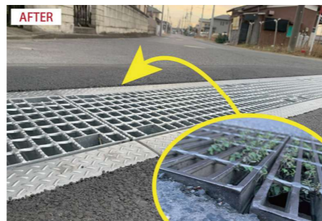
排水路の交換（福富町）
