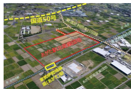
あがた駅北産業団地航空写真（令和4年6月撮影）
