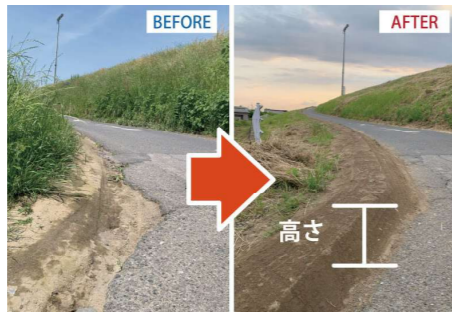
崩れた路肩を補修（福富町）
