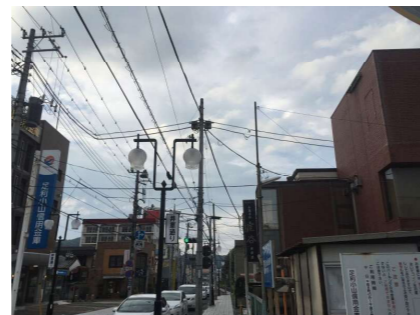
電線が縦横無尽に走るシンボルロード
