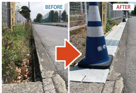
福富公園北側の道路水路に蓋を設置
