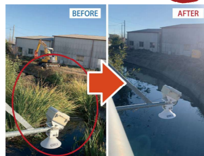
除草・浚渫が実施された塩島橋付近
