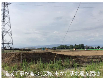
造成工事が進む(仮称)あがた駅北産業団地
