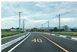
市道福富久保田通り拡幅工事の推進
